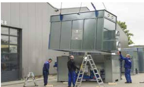
Поместите два верхних модуля на модуль выгрузки
