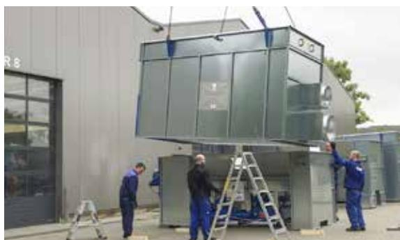
Поместите два верхних модуля на модуль выгрузки
