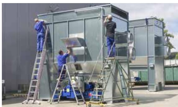
Смонтируйте сухотруб, пламеотвод, управление регенерацией и подключите двигатели. Все готово.
