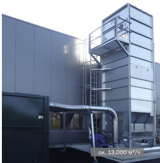
Фильтр MultiStar со шлюзом с загрузкой в контейнер
