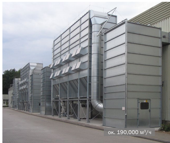
Фильтр MultiStar с каналом обратного воздуха с элементом приточной вентиляции • производство кухонной мебели
