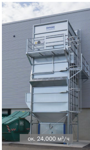
Фильтр MultiStar с прессом • полиграфия
