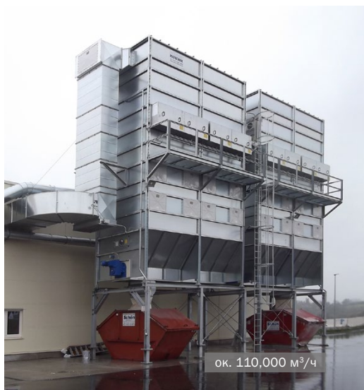
Фильтр MultiStar со шнеком, с импульсной регенерацией • внутренняя отделка
