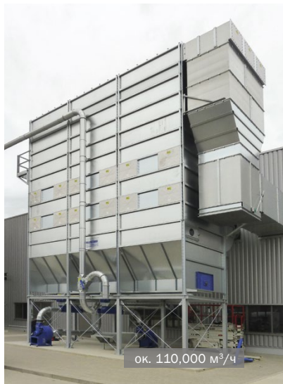
Фильтр MultiStar со шнеком, с продувочным воздухом
