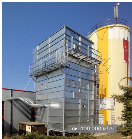
Фильтр MultiStar с ворошителем с импульсной регенерацией
