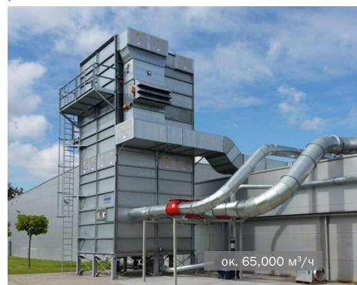
Фильтр MultiStar с ворошителем • производство фанеры
