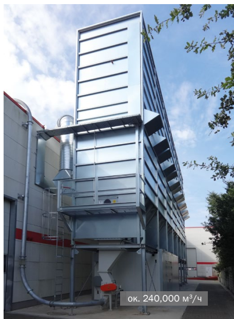
Фильтр MultiStar с каналом обратного воздуха с элементом приточной вентиляции • производство кухонной мебели
