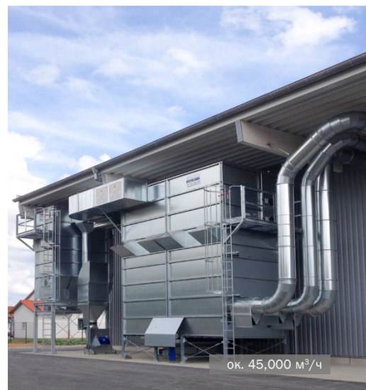
Фильтр MultiStar с импульсной регенерацией • производство сборных домов
