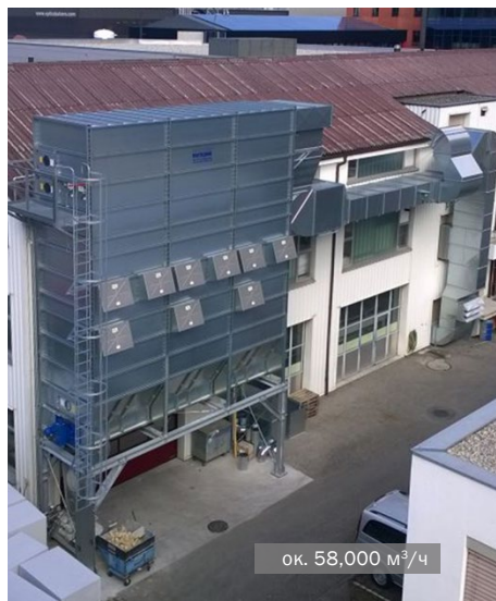
Фильтр MultiStar со шнеком, с продувочными тележками • внутренняя отделка
