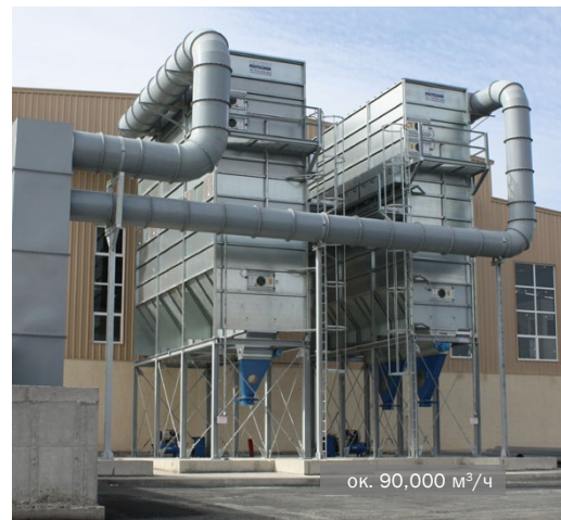
Фильтр MultiStar с импульсной регенерацией в перерабатывающей промышленности
