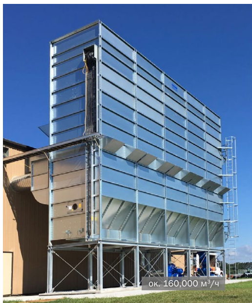
Фильтр MultiStar с каналом обратного воздуха • мебельная промышленность
