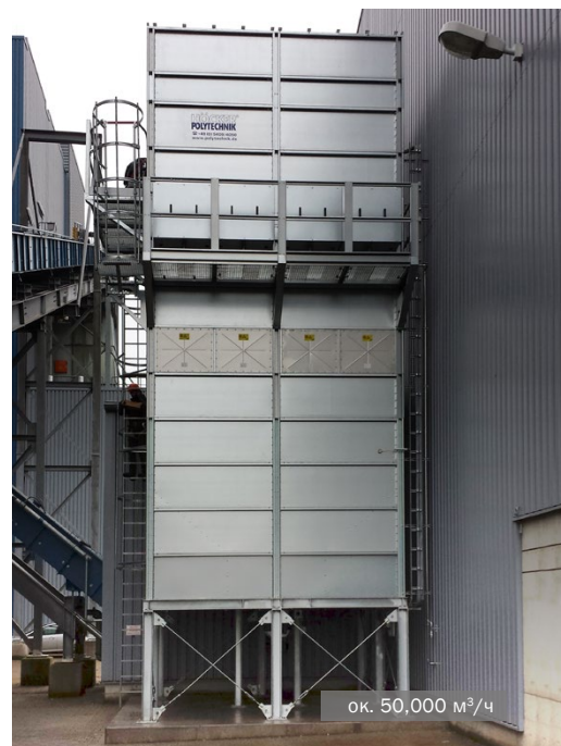
Фильтр MultiStar с ворошителем • энергоустановка, работающая на биомассе
