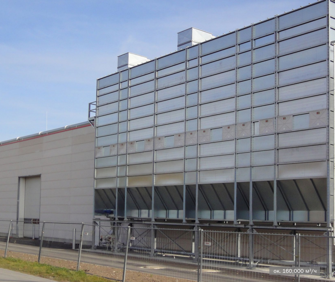
Фильтр MultiStar с каналом обратного воздуха с элементом приточной вентиляции • мебельная промышленность
