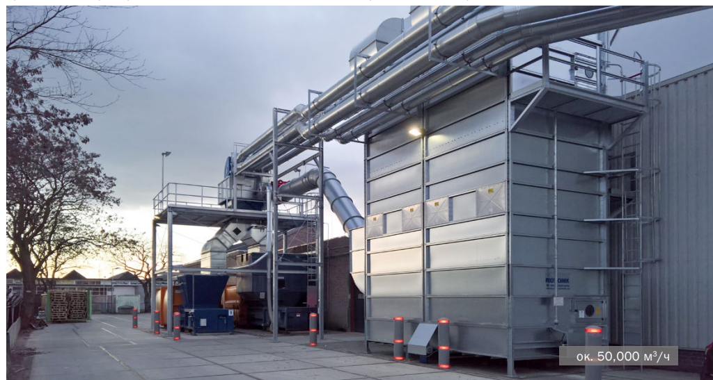
Фильтр MultiStar с импульсной регенерацией с направляющими планками • полиграфия и производство упаковки
