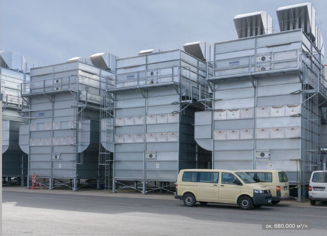
Фильтр MultiStar с ворошителем с импульсной регенерацией • производство кухонной мебели
