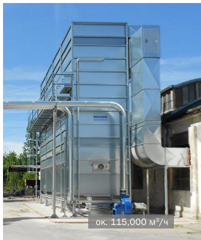
Фильтр MultiStar с каналом обратного воздуха • мебельная промышленность
