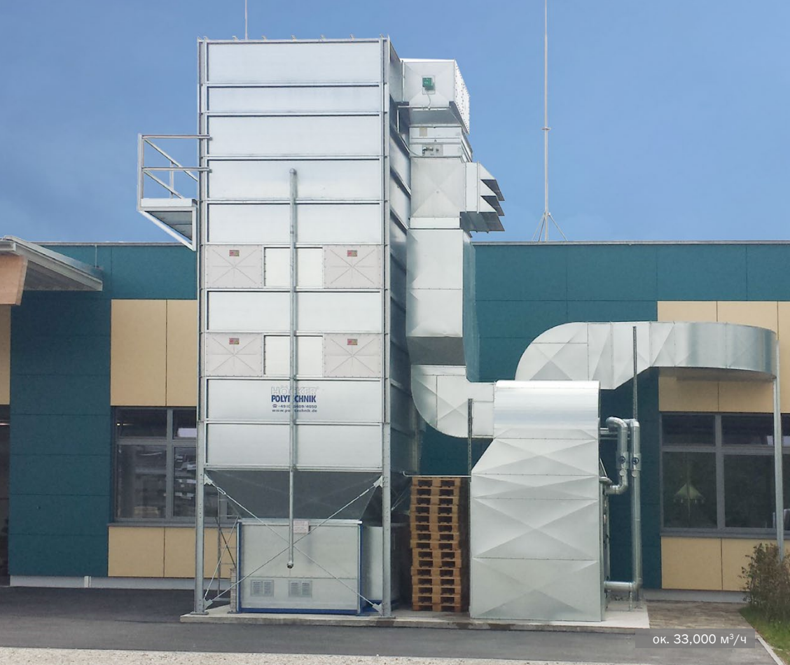
Фильтр MultiStar с прессом и рекуперацией тепла • ПТУ
