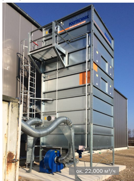
Фильтр MultiStar с ворошителем • производство ламината
