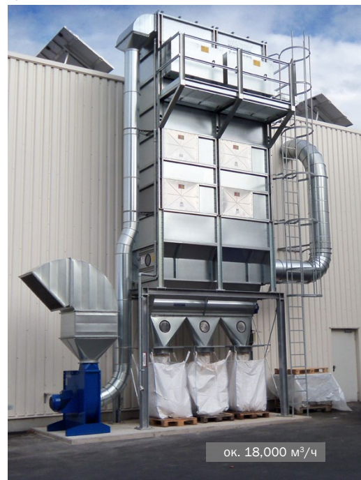
Фильтр MultiStar с импульсной регенерацией в производстве сборных домов
