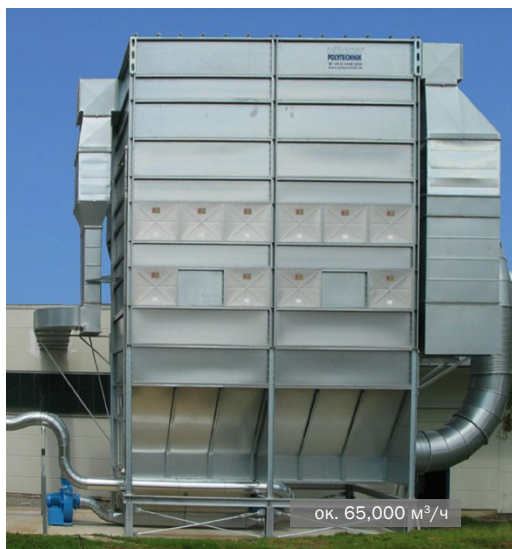
Вакуумный фильтр MultiStar со шлюзом • поставки мебели
