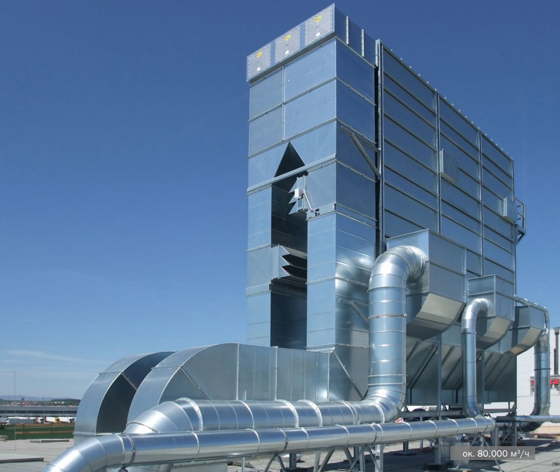
Фильтр MultiStar со шнеком и регенерацией продувочными тележками • производство спортивного оборудования
