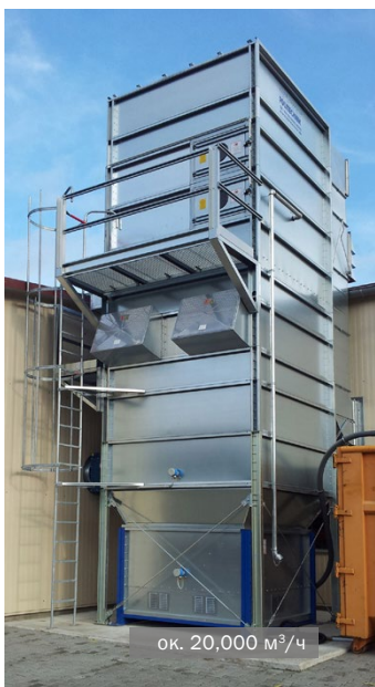
Фильтр MultiStar с прессом • внутренняя отделка
