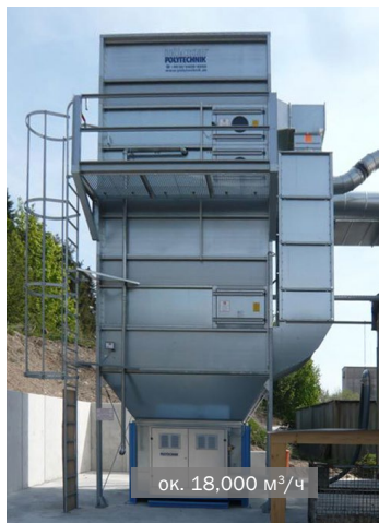
Фильтр MultiStar с прессом • внутренняя отделка
